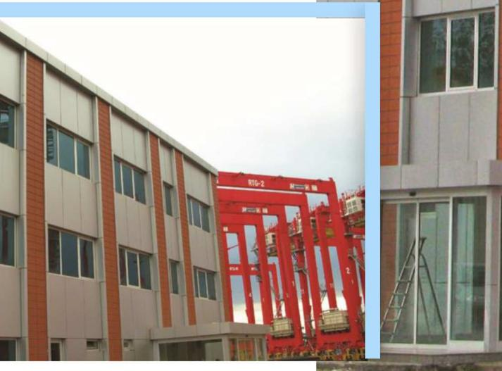
T R | Isı yalıtımlı alüminyum doğrama, alüminyum, kompozit panel kaplama, kreaton taş kaplama, alüminyum kapaklı cam cephe otomatik kapı sistemi
