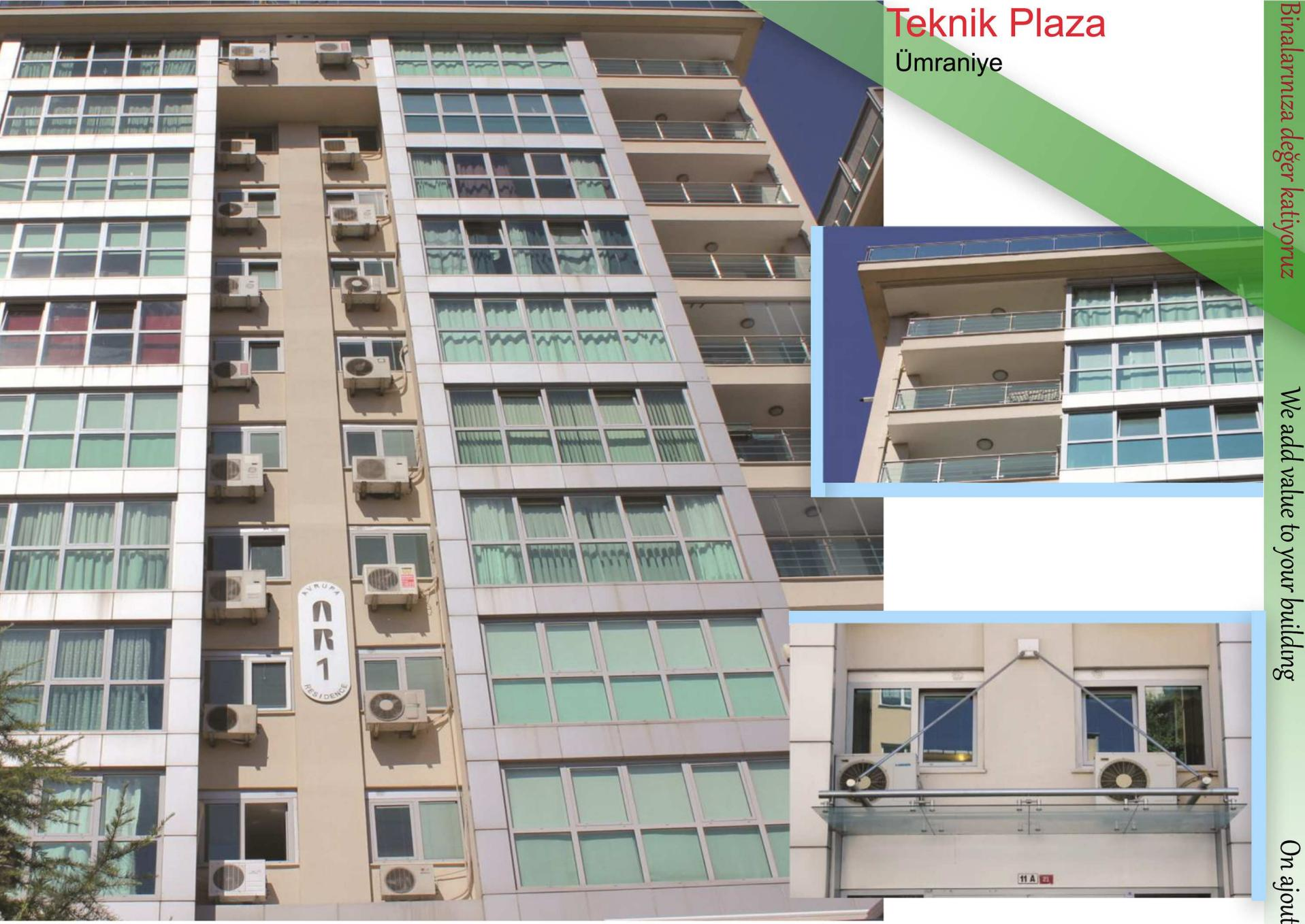
T R ısı yalıtımlı alüminyum doğrama, alüminyum kompozit panel kaplama, pastamaz cam saçak, cam küpeste
