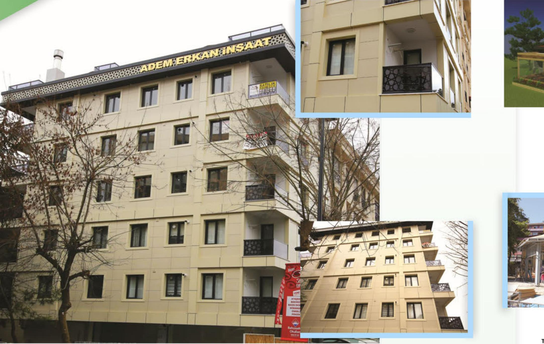
T R Alüminyum kompozit panel kaplama, seramik, cephe kaplama, alüminyum camlı küpeste, ısı yalıtımlı alüminyum
