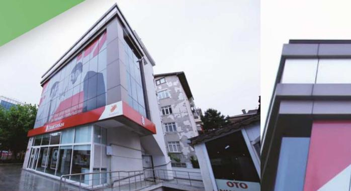
T R | Alüminyum strüktürel silikon cam cephe kaplama, ısı yalıtımlı alüminyum doğrama, alüminyum, kompozit panel kaplama
