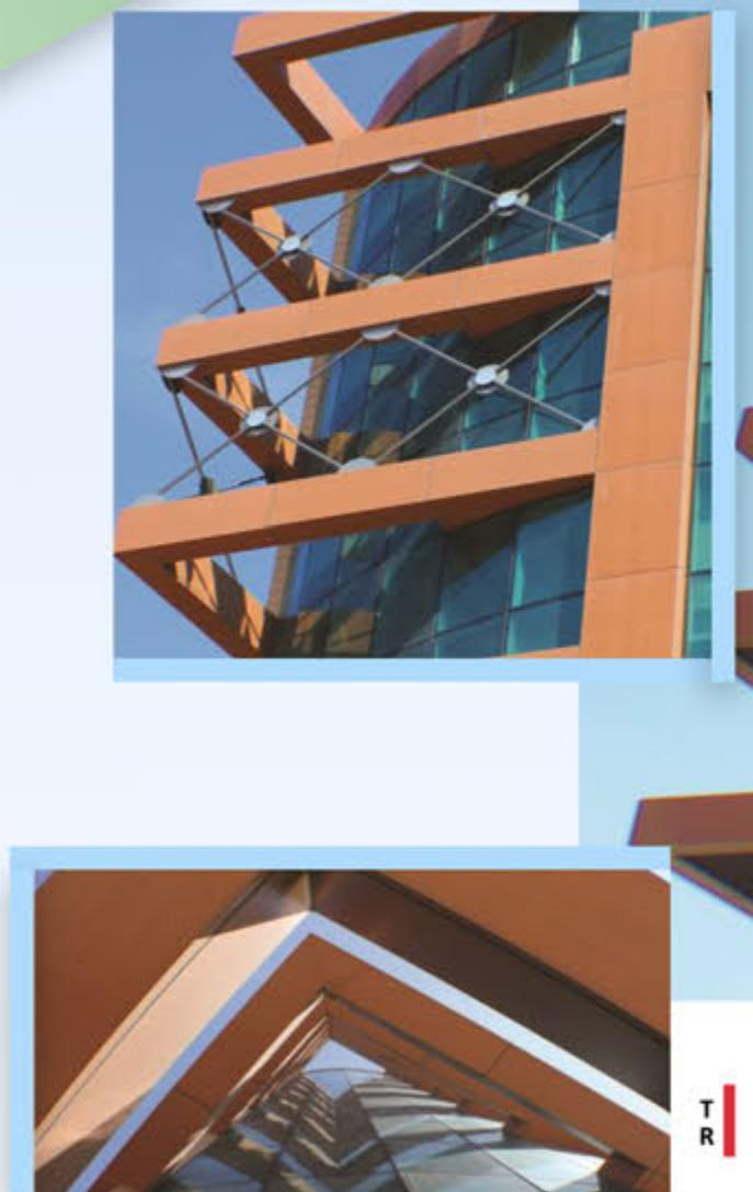
T R Alüminyum strüktürel silikon cam cephe
