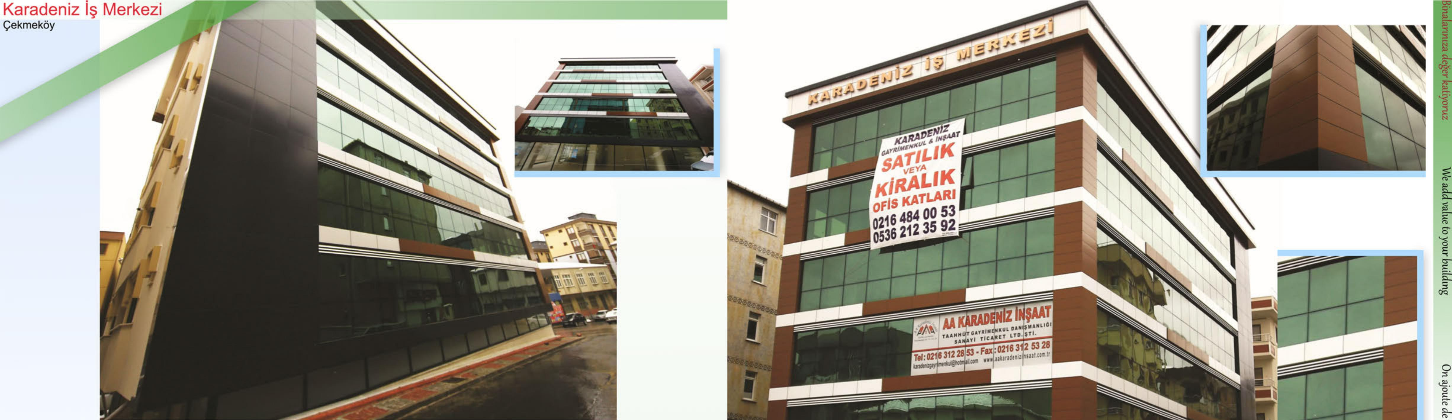
T R Alüminyum strüktürel silikon cam cephe.
