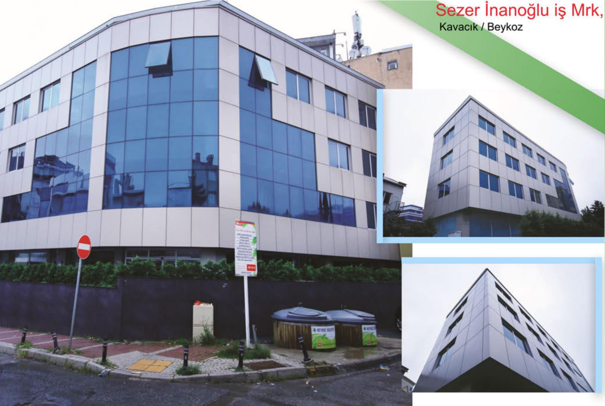
T R Alüminyum strüktürel silikon cam cephe kaplama, ısı yalıtımlı alüminyum doğrama, alüminyum, kompozit panel kaplama
