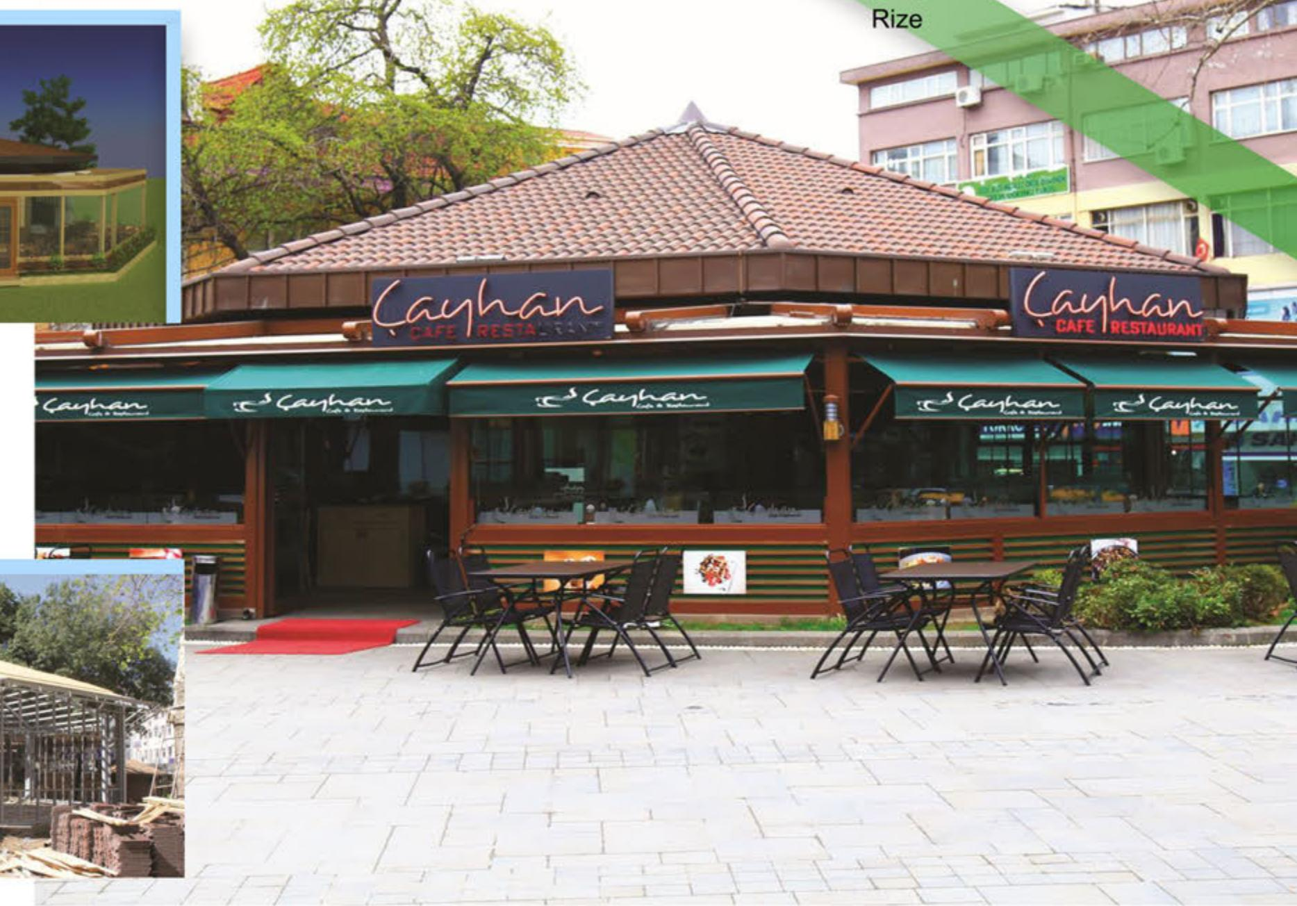
T R Özel tasarım çelik konstrüksiyon, doğal ahşap, kaplı alüminyum cotta, ısı yalıtımlı alüminyum, doğrama ve katlanır cam, otomatik kapı.
