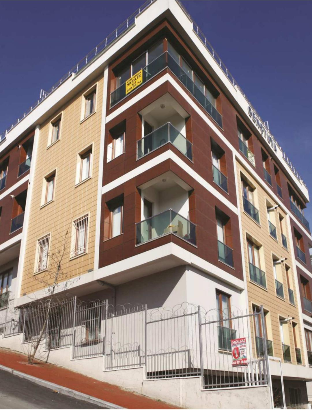
T R alüminyum doğrama, alüminyum, kompozit panel kaplama, alüminyum küpeşte, alüminyum camlı küpeşte, kreaton taş kaplama
