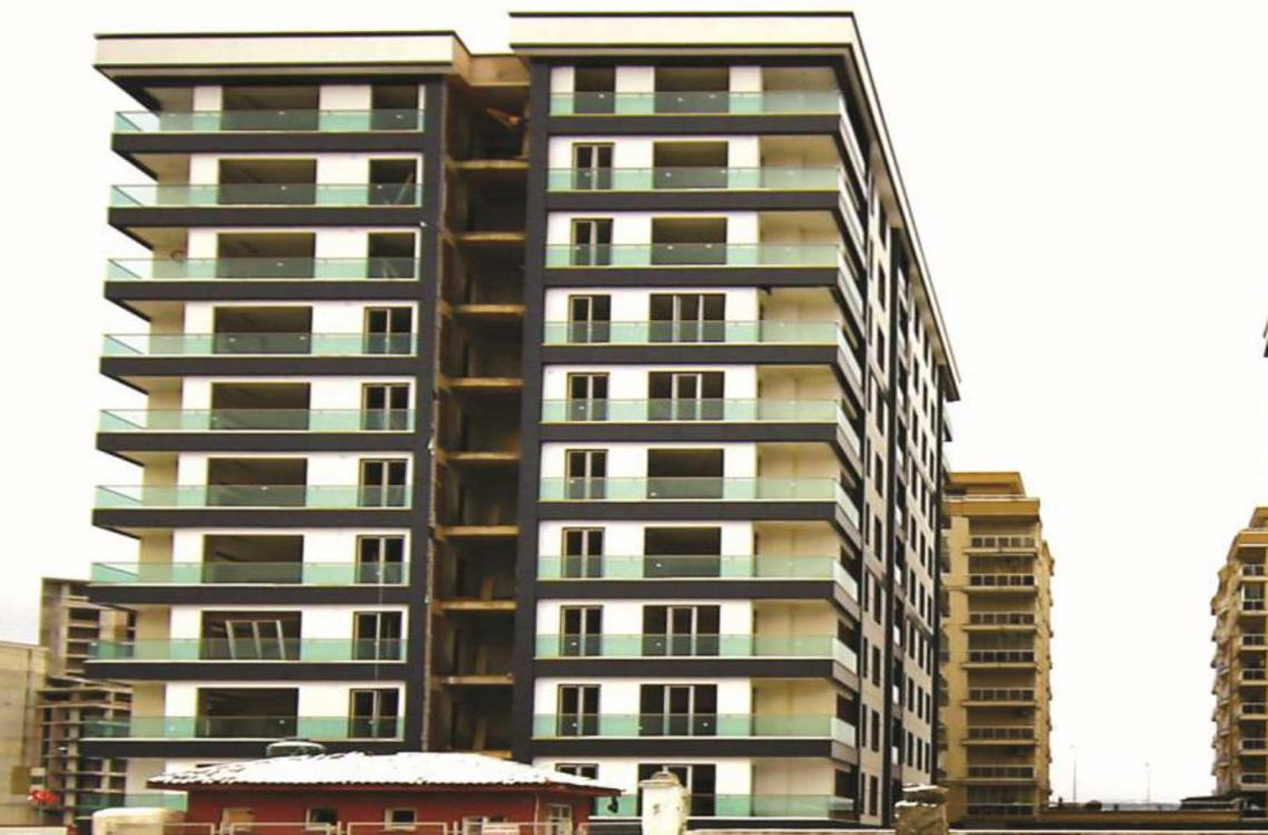
TR Alüminyum kompozit panel kaplama,
